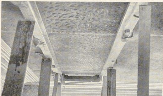
Bild 367. Abgesteifte Latten als Anschlag für den Deckenzug
