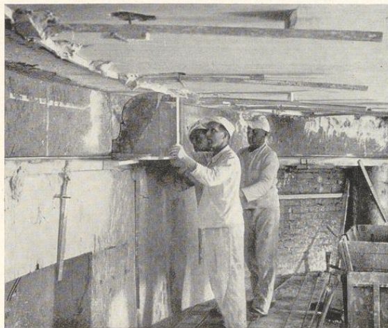
Bild 420. Einrichten eines gebogenen Gesimszuges
