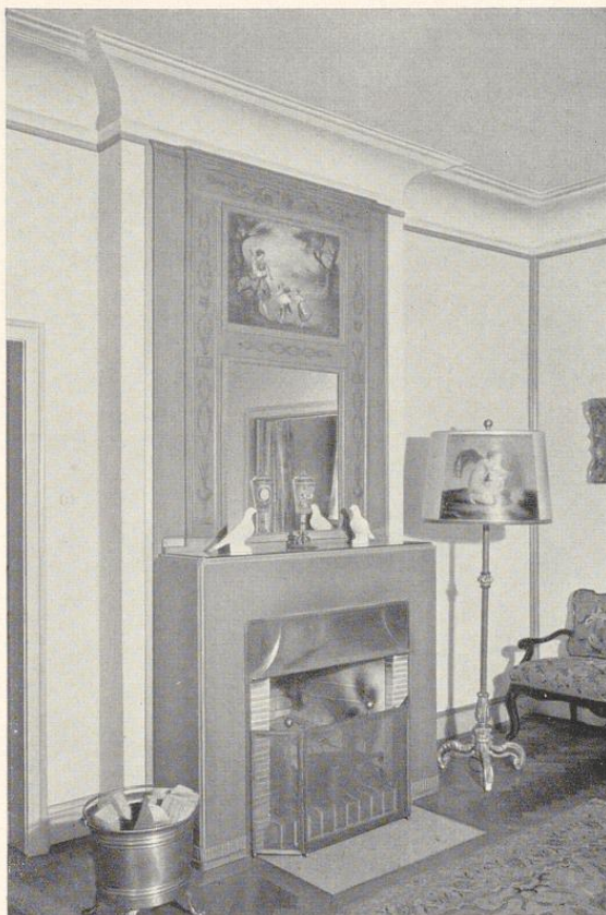
Bild 469. Eckgesims mit Verkröpfungen am Kamin
