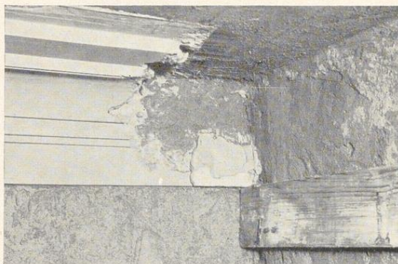
Bild 384. Der Gipspunkt im Eck als Anhaltspunkt für den Lattenanschlag des Querzuges. Der Gipspunkt muß oberhalb der Latte sitzen
