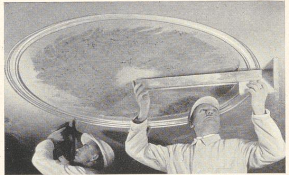
Bild 432. Kreiszug an der Decke mit der Radiuschablone
