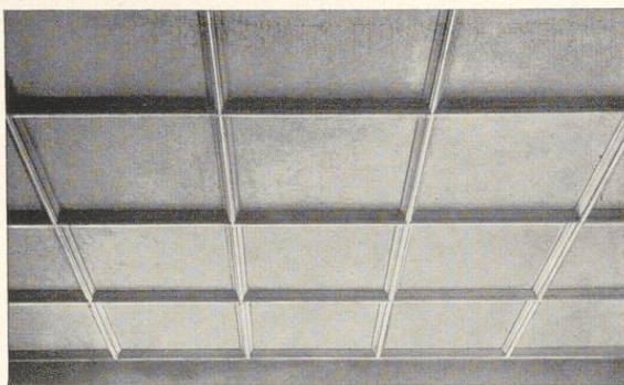
Bild 493. Fertige Stuckdecke mit eingesetzten Stäben
