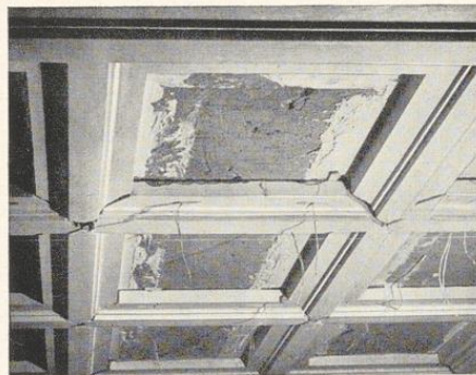
Bild 498. Einsetzen der gezogenen Querbalken. Mit eisernen Knebeln aufgehängt
