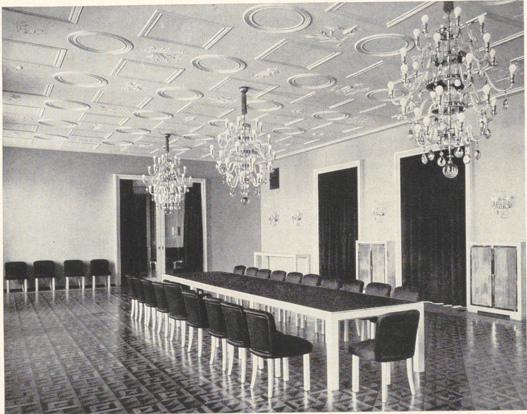
Bild 487. Stuckdecke mit Antragarbeit im Speise- und Festsaal des Palastes von Ghazi Kemal Pascha (Atatürk), Ankara. Architekt Clemens Holzmeister, Wien
