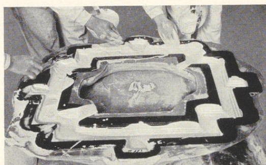
Bild 504. Gießen der Kassettenstücke aus der Leimform zur Stuckdecke Bild 506
