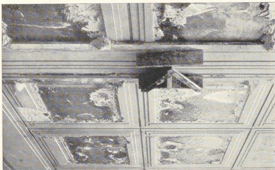
Bild 511. Ziehen der vertieften Kassettenprofile über Kreuz. Lattengang geht über die fertigen Profile
