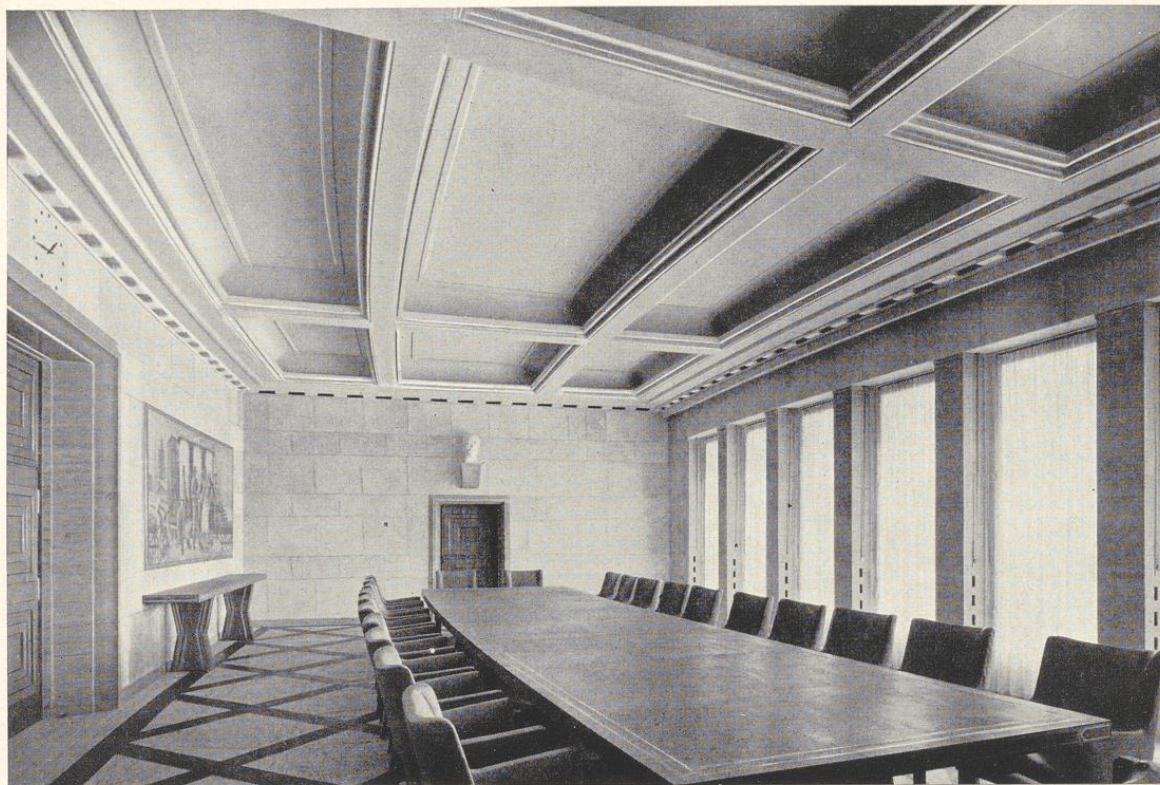
Bild 517. Kassettierte Stuckdecke mit indirekter Beleuchtung bei Tag. Verwaltungsgebäude der Chemischen Industrie, Berlin
