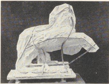
Bild 548. Die Eiseneinlagen zur Verstärkung der Schale sind aufgelegt
