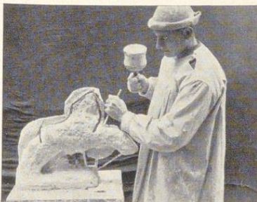
Bild 554. Die äußere weiße Gipsschale mit der Armierung wird abgeschlagen
