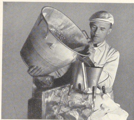
Bild 568. Ausführung von Leimguß mit Eimer und Trichter
