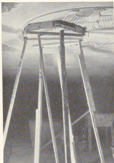
Bild 600. Anquetschen an der Decke aus der Spiegelleimform
