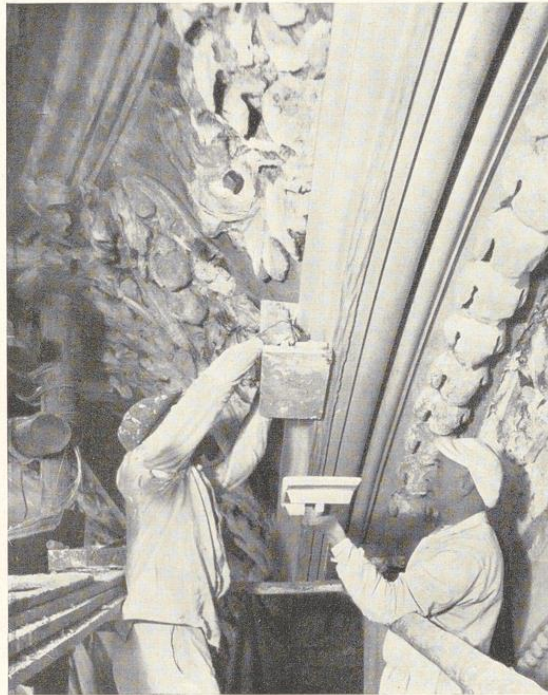
Bild 645. Nachziehen eines großen Stückgesimses beim Wiederaufbau der Theatinerkirche in München. Ausführung Stückgeschäft Fritz Bender, München
