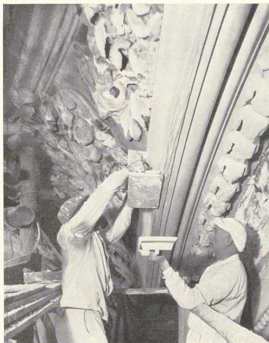
Bild 645. Nachziehen eines großen Stückgesimses beim Wiederaufbau der Theatinerkirche in München. Ausführung Stuckgeschäft Fritz Bender, München
