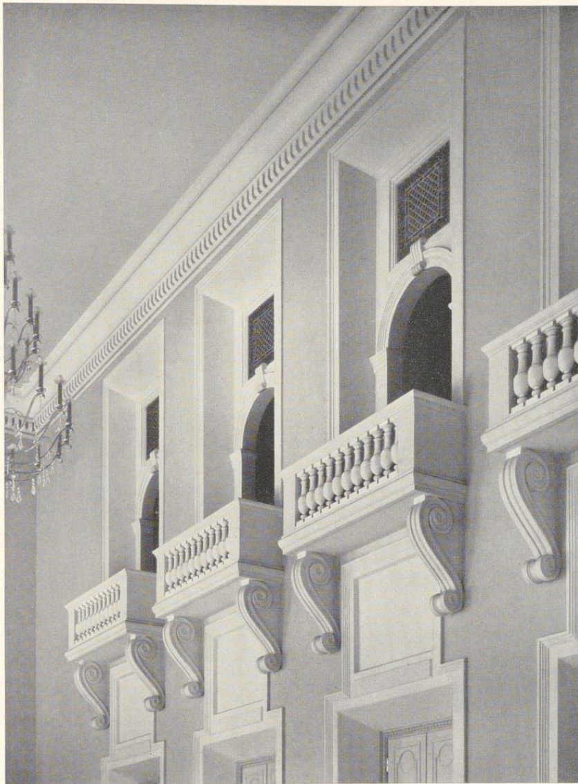
Bild 646. Festsaal des wiederaufgebauten Schlosses in Koblenz mit umfangreichen Stuckarbeiten, in Zug-, Guß- und Setztechnik ausgeführt. Staatl. Hochbauamt Koblenz. Ausführung Kunstwerkstätten Professor Lauermann, Düsseldorf-Grafenberg
