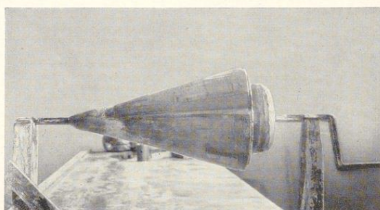
Bild 670. Runder Gipskern zum Abdrehen eines Säulenkopfes
