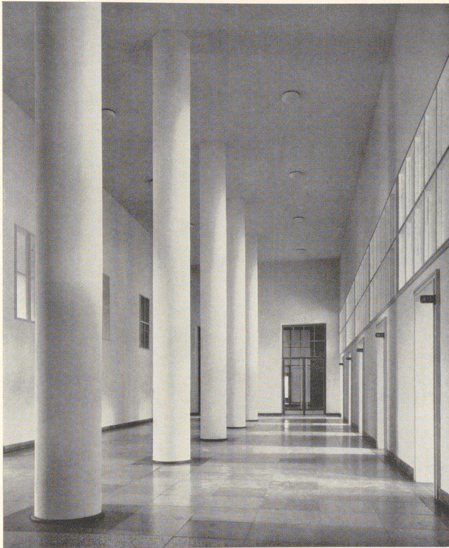
Bild 683. Konstruktionsstützen in einer Halle, durch Rabitz- und Stuckummantelung als Säulen ausgebildet
