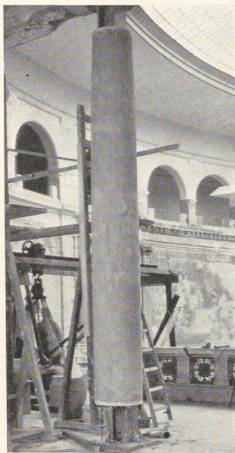
Bild 701. Grundierte Säule zur Aufnahme der Marmormasse
