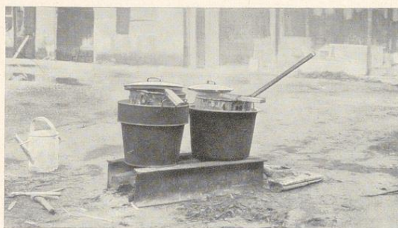
Bild 602. Schmelzen des Leims im Wasserbad auf der Baustelle
