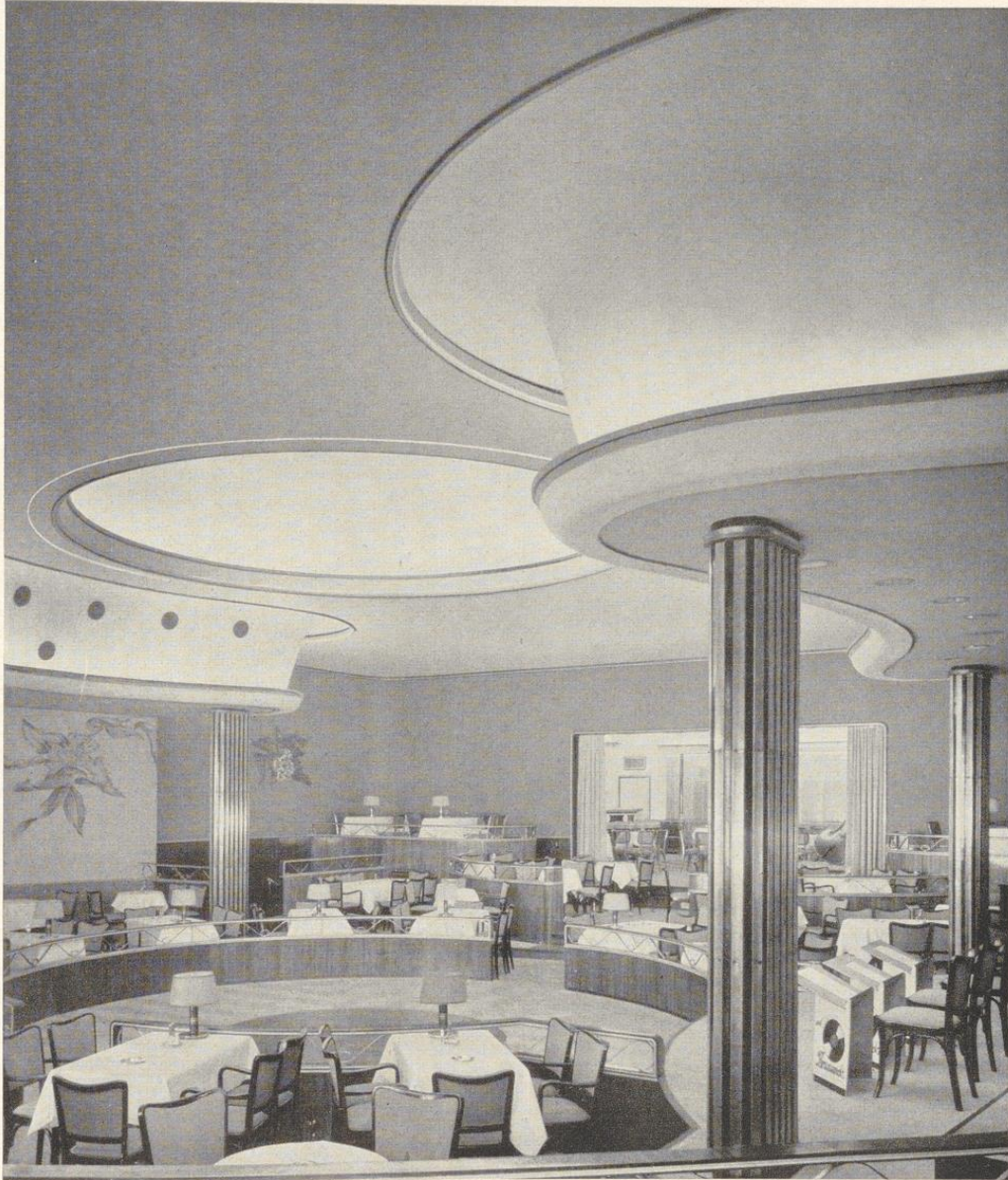
Bild 737. Rabitzdecken mit indirekter Beleuchtung im Weinrestaurant Tabaris, Düsseldorf. Architekt Ernst Huhn, Düsseldorf. Ausführung Georg Becker & Co., Düsseldorf
