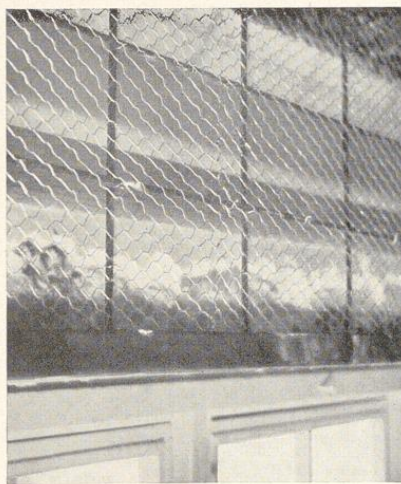
Bild 751. Rabitzkonstruktion für einen Rolladenkasten
