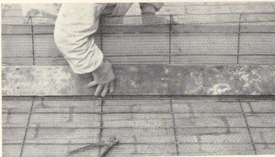
Bild 757. Abbiegen von Baustahlmatten mit 2 Brettern auf der Baustelle
