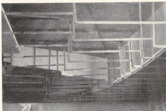
Bild 762. Flacheisenkonstruktion für den Entlüftungskanal
