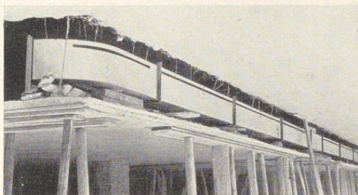
Bild 765. In Rabitzdecke eingebauter Entlüftungskanal. Universum-Filmtheater, Stuttgart
