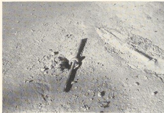
Bild 776. Befestigung von zwei untereinanderliegenden Kanälen in der Betondecke
