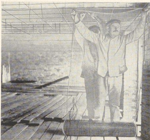
Bild 793. Aufziehen und Anheften des Rabitzgewebes
