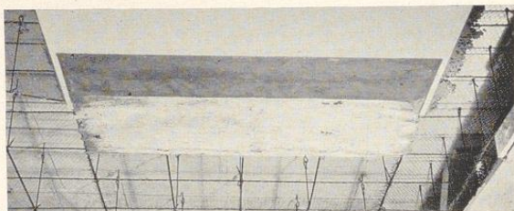
Bild 790. Rabitzdecke nach Gipsleisten, teilweise grundiert und fertig geputzt
