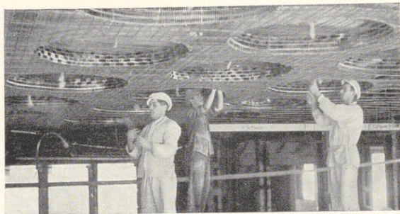
Bild 808. Rabitzdecke mit runden Vertiefungen für Beleuchtungskörper. Ausführung Stukkateurmeister E. Schwarz, Stuttgart-Hedelfingen
