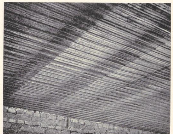
Bild 829. Holzbalkendecke mit Rippenstreckmetall überspannt (ohne Rundeisenbewehrung)
