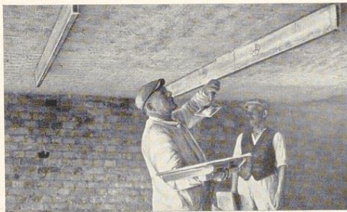
Bild 796. Anwerfen der Gipslehen in den Zwischenraum der aufgebundenen Lehrlatten
