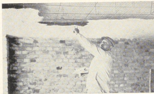
Bild 795. Ausdrücken des Gewebes mit Gipshaarkalkmörtel. Der Mörtel wird möglichst dünn aufgetragen
