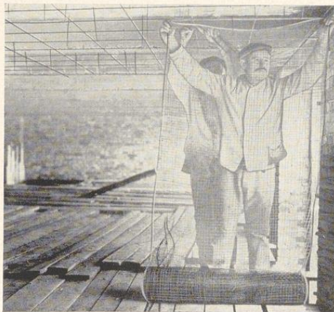
Bild 793. Aufziehen und Anheften des Rabitzgewebes
