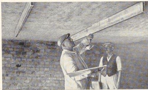
Bild 796. Anwerfen der Gipslehren in den Zwischenraum der aufgebundenen Lehlatten
