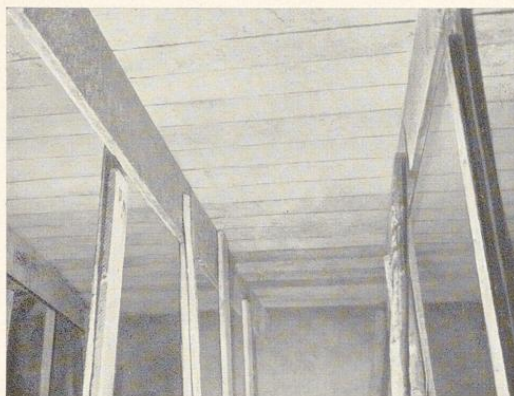
Bild 800. Vom Gerüst aus gestützte Schalung für eine Gußrabitzdecke
