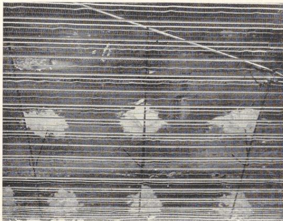
Bild 828. Rippenstreckmetall als Bewehrung für Rabitzdecke unter Massivdecke
