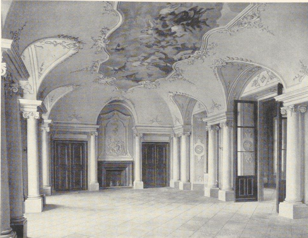
Bild 832. Tonnengewölbe mit Stichkappen im Schloß Hetzendorf bei Wien, um 1742
