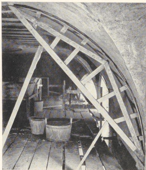
Bild 847. Auf Kämpferlatten eingesetzter Lehrbogen am Spitzbogen-Kreuzgewölbe
