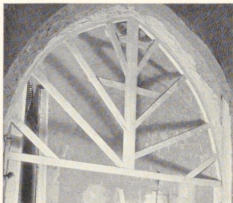
Bild 847. Auf Kämpferlatten eingesetzter Lehrbogen am Spitzbogen-Kreuzgewölbe
