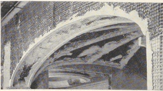
Bild 864. Flache Gipslehren an einem Gurtbogen
