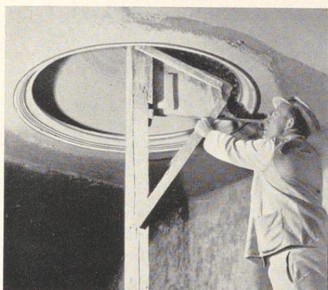
Bild 972. Kleine Rundkuppel für indirekte Beleuchtung, mit dem drehbaren Flügel gezogen
