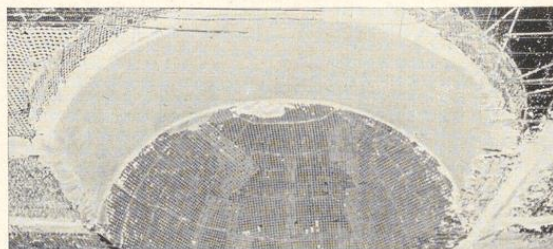
Bild 910. Die Gewölbefläche nach Gipslehen teilweise grundiert
