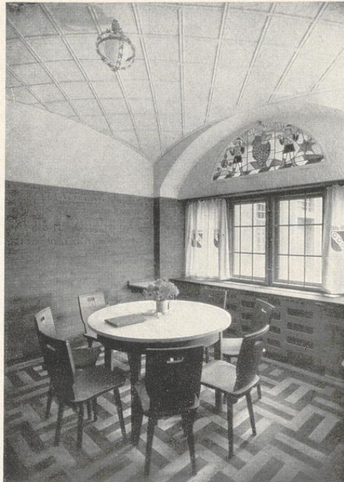
Bild 1006. Böhmische Kappe mit frei angetragenen Stuckstäben. Weinausschank des Juliusspitals in Würzburg. Architekt Max Wiederanders, München. Stuckarbeit A. Menna, Würzburg
