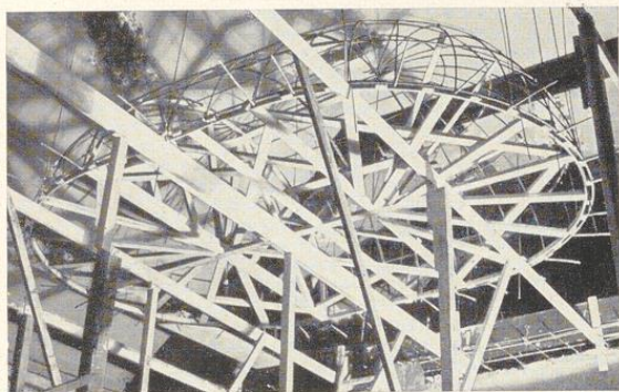
Bild 905. Das Rundeisengerippe mit dem Lehrgerüst von unten gesehen
