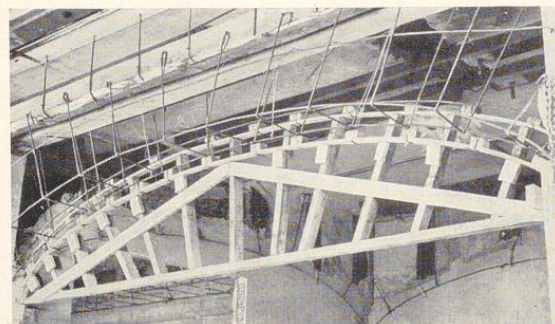
Bild 842. Eingesetzter doppelter Lehrbogen mit aufgebundener Rundeisenstange für den Gurt- und Stirnbogen
