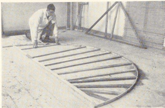
Bild 840. Lehrbogen in Halbkreisform für ein Tonnen- oder Kreuzgewölbe
