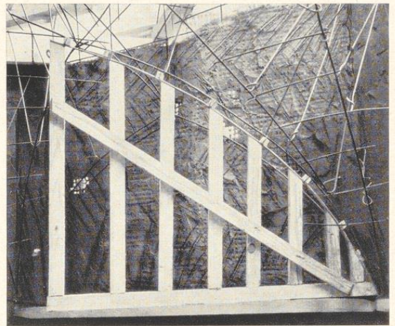
Bild 848. Halber Lehrbogen zum Einsetzen der Grat- und Kehlstan-gen für ein Sterngewölbe
