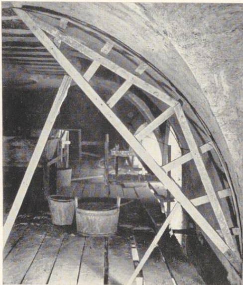
Bild 847. Auf Kämpferlatten eingesetzter Lehrbogen am Spitzbogen-Kreuzgewölbe
