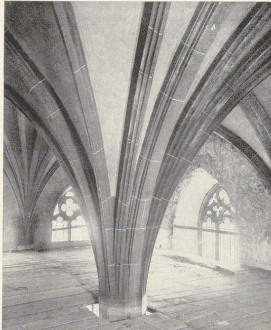
Bild 965. Der fertiggestellte Pfeiler. Die profilierten Rippen sind in gefärbtem Estrichgipsmörtel gezogen, die Felder in Kalkmörtel abgerieben
