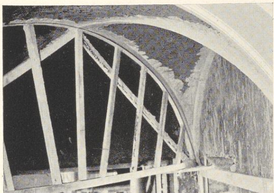
Bild 933. Anlegen der Gipslehren mit Hilfe des Lehrbogens
