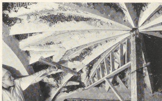
Bild 991. Anlegen der Kehllehren mit dem Flügel, die Zwischengrate werden von Hand herausgezogen
