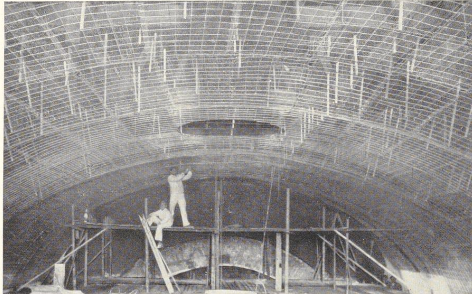
Bild 880. Großes Tonnengewölbe aus Baustahlmatten mit runder Aussparung für Entlüftungsrosette. Katholische Kirche, Neckarsulm. Architekt Richard Schumacher, Heilbronn a. N. Ausführung Stuckgeschäft Wilhelm Denz, Neckarsulm
