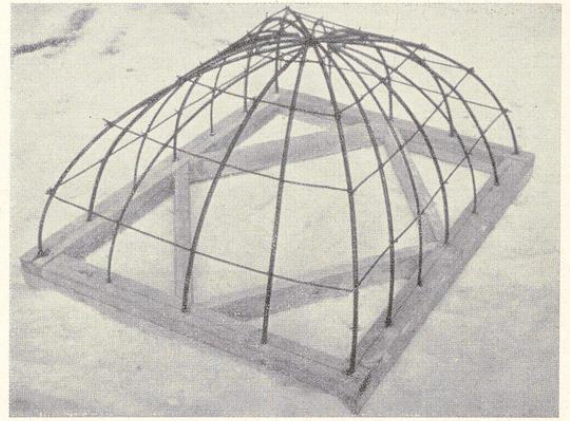
Bild 892. Klostergewölbe über quadratischem Grundriß
