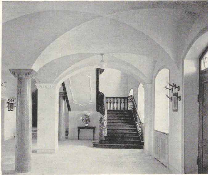
Bild 930. Kreuzgewölbe mit waagrechtem Scheitel in einer Vorhalle. Architekt Hugo Schlösser, Stuttgart
