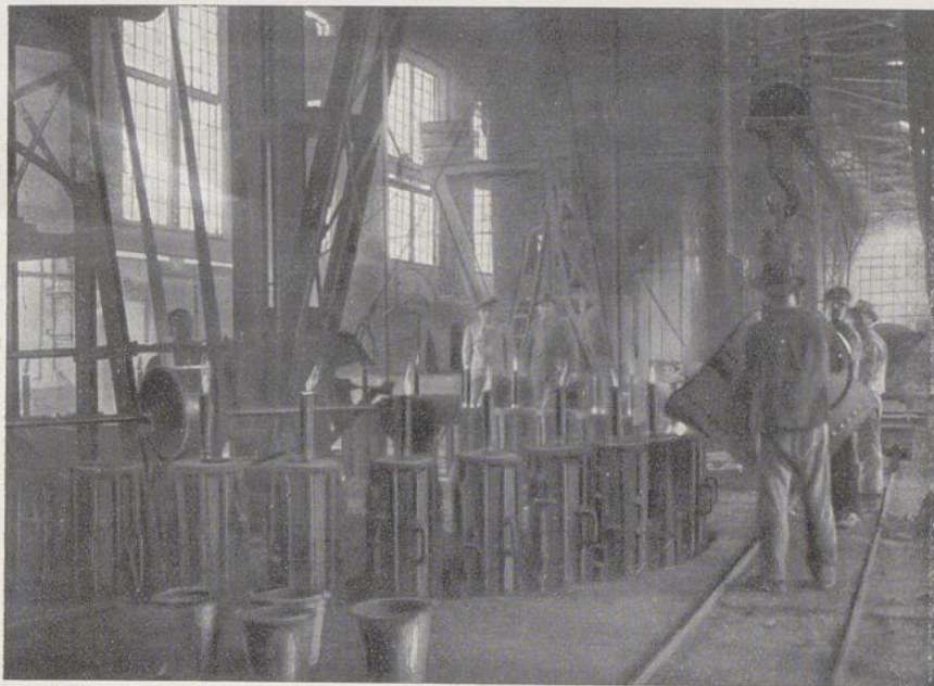
Röhrenguß im Eisen- und Stahlwerk der Gelsenkirchener Bergwerks- und Aktiengesellschaft.
