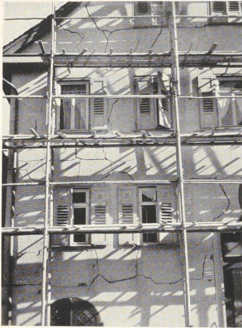
Bild 275. Außenputz auf Holzfachwerk. Die Risse sind hier auf ungenügende Verwahrung des Holzwerks (Fehlen der Isolierung) zurückzuführen. Zur Überarbeitung des Verputzes sind die Risse bereits aufgerissen
