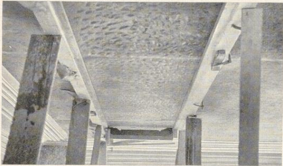
Bild 367. Abgesteifte Latten als Anschlag für den Deckenzug
