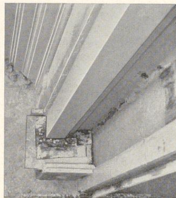
Bild 378. Anschlag am Unterzug mit Blindwand
