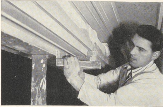
Bild 375. Führung der Schablone am Unterzug mit Hochdruck
