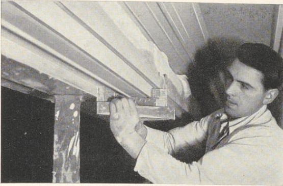
Bild 375. Führung der Schablone am Unterzug mit Hochdruck
