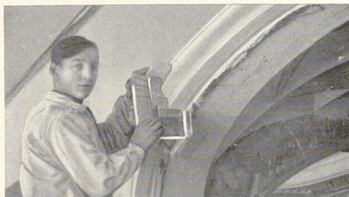
Bild 411. Die senkrecht drehbare Ladenschablone zum Ausziehen einer runden Nische
