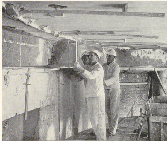
Bild 420. Einrichten eines gebogenen Gesimszuges
