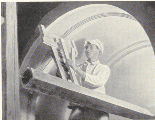
Bild 458. Profilzug am Gewölbe mit liegender Flügelschablone
