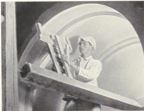
Bild 458. Profilzug am Gewölbe mit liegender Flügelschablone
