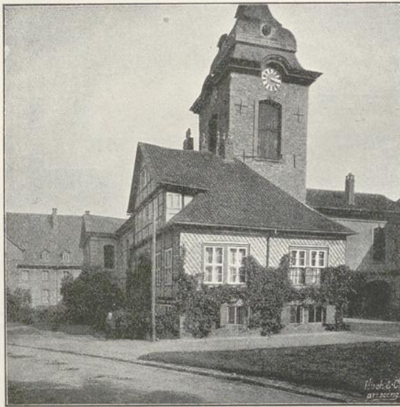
38. Steterburg, Kirche mit Wohnhaus.
