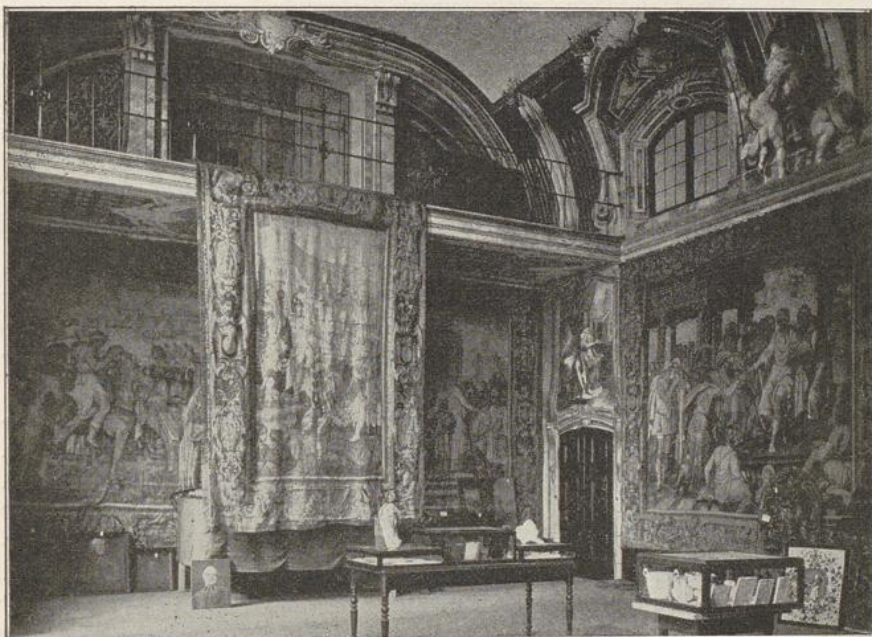
Fig. 92. Hildesheim Rittersaal im Obergeschoß des südlichen Domkreuzganges.
