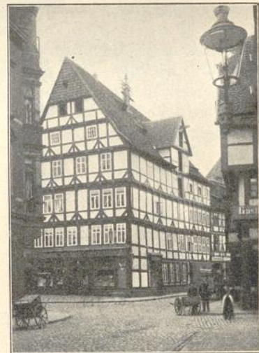
Fig. 254. Eckhaus Langer Hagen—Kurzer Hagen.
