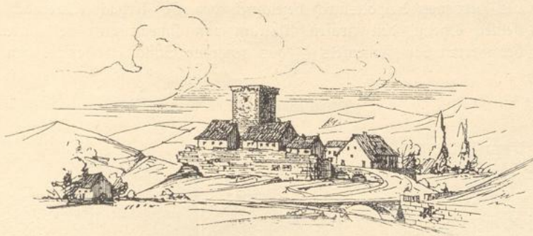
Ansicht gegen Südwesten.
