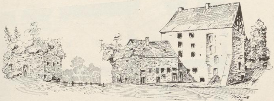
Fig. 87. Burgruine Steinbrück; Blick in den inneren Burghof.
