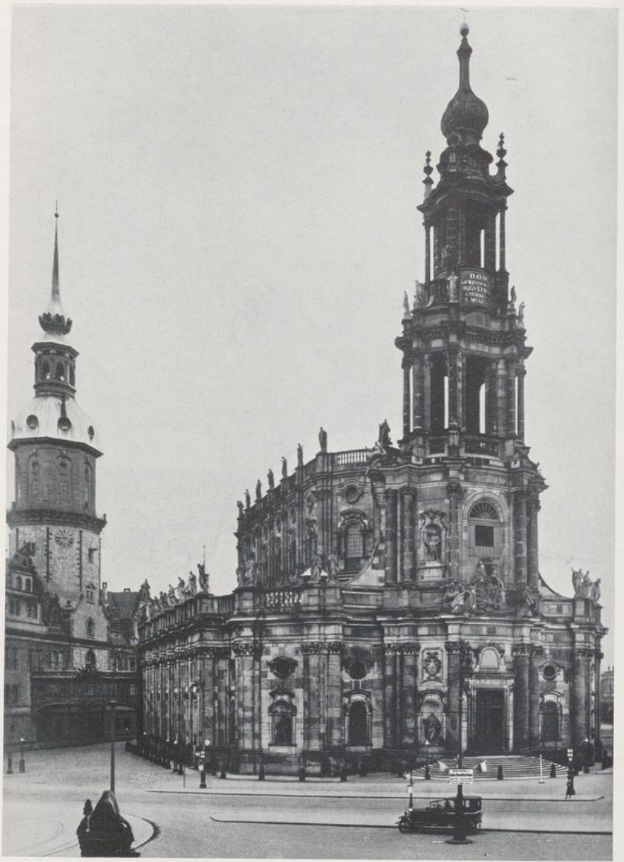
483. Dresden, Katholische Hofkirche, Turmfassade, 1738—46.
