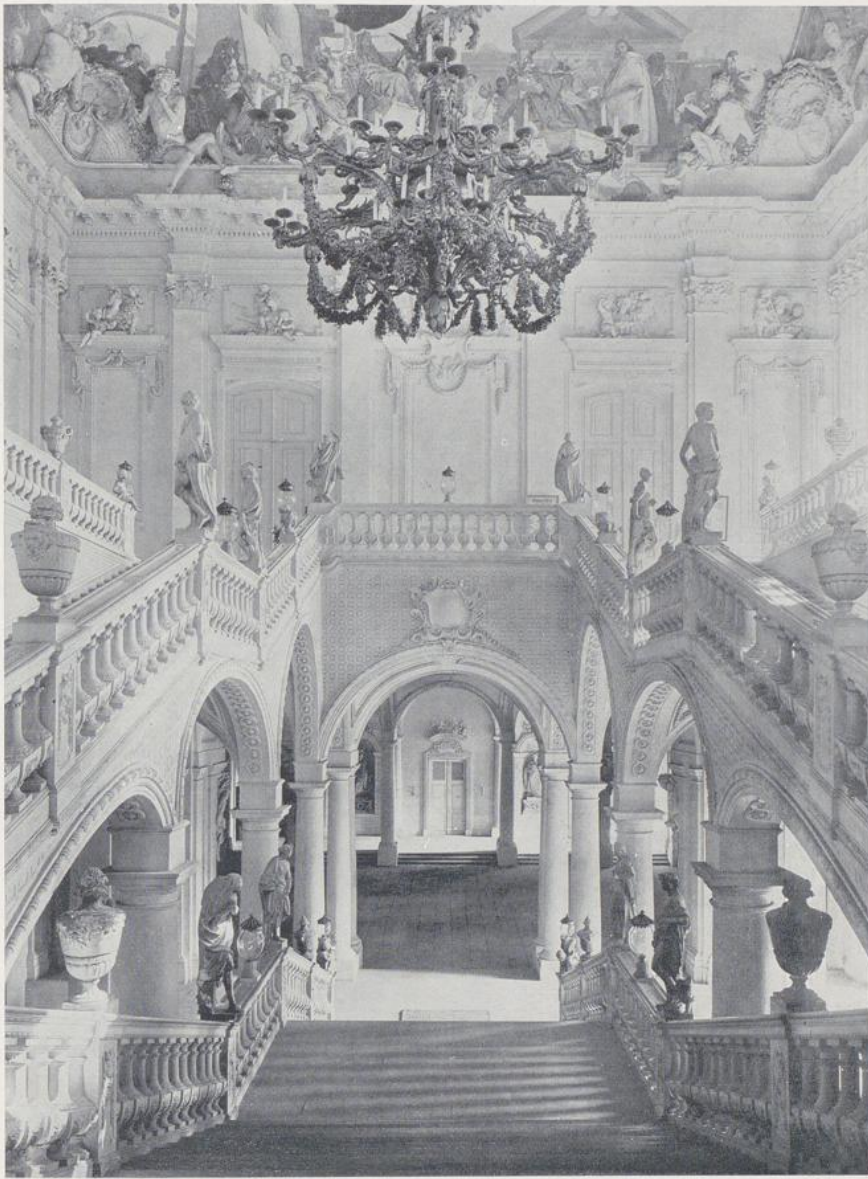
616. Treppenhaus in der Residenz zu Würzburg, heutiger Zustand, Rohbau von 1737—1744, Ausstattung 1765—1775.
