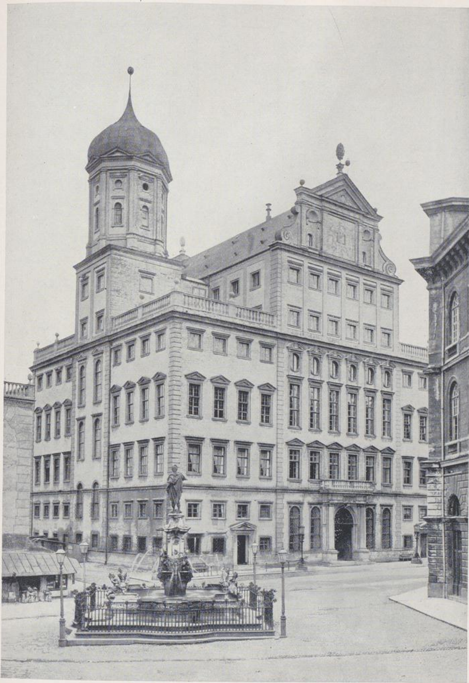
364. Augsburg, Rathaus, Fassade, 1615—20, im Vordergrund Augustusbrunnen.
