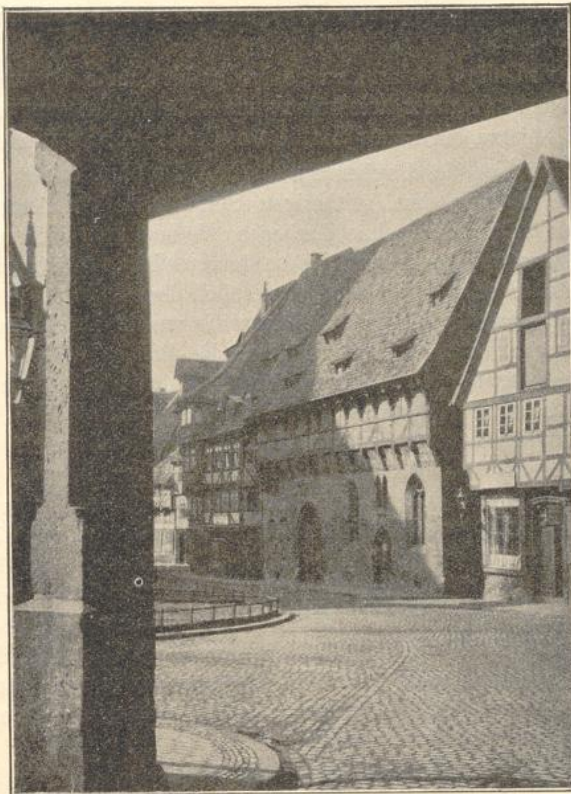
Fig. 44. Heiliges Geistspital. Von der Durchfahrt des Pfeilerhauses aus gesehen.
