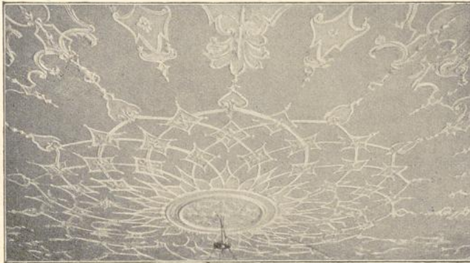
Fig. 112. Domhof 27/28. Domdechaneel. Stuckdecke im zweiten Zimmer. Obergeschoß des Vorderhauses
